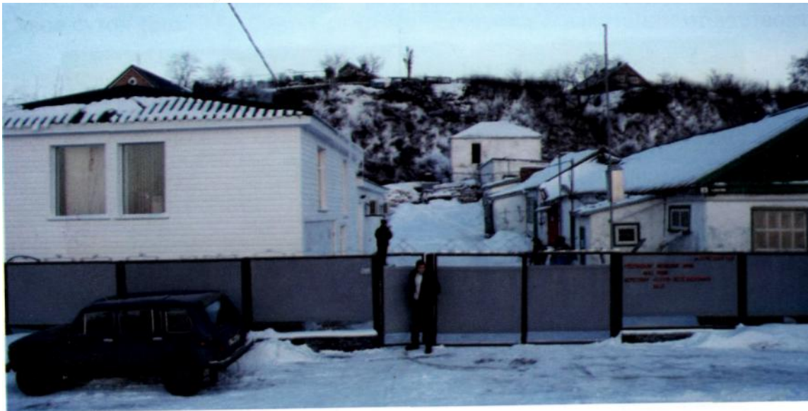
Рис. 21. Здание рыбоводного комплекса «Кагальник»
