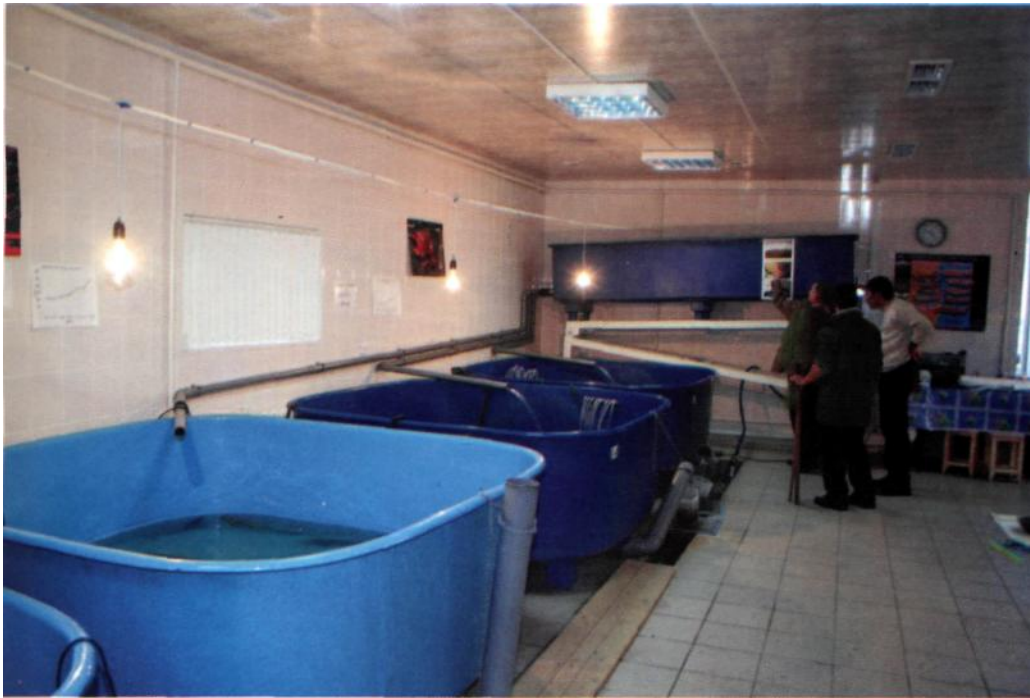
Рис. 30. Установка замкнутого водообеспечения в рыбоводном комплексе «Кагальник»
