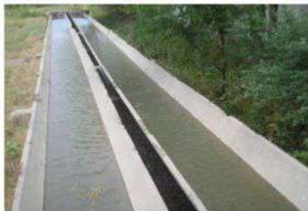
Рисунок 9 – Бетонный бассейн, используемый для разведения дафнии magna
