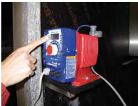
Иллюстрация 2.17 Насос-дозатор для регулирования рН путем добавления заранее заданных количеств NaOH. Для полной автоматизации регулирования уровня рН насос может быть подключен к датчику рН.
